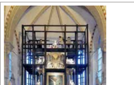
The Project A Renovation of St Mary's Cathedral after the 2000 fire Püha Marija Katedraali renoveerimine pärast 2000. aasta tulekahju Location Tallinn Author EKA Sisearhitektuur Year 2017 B Cathedral "Reconstruction" Katedraali "Rekonstruktsioon" Location Tallinn Author Gunter Reinhold Year 1944
